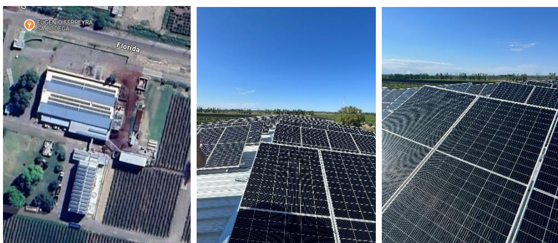
Foto 9. Imagen de Google Maps del establecimiento de Eugenio Ferreira y de los paneles solares instalados
