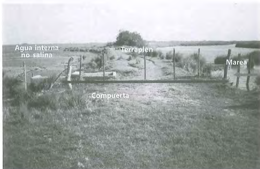
FOTO 6.10. La foto muestra un sistema tubo-compuerta para manejar el agua interna y externa del establecimiento Los Zorzales, partido de Gral. Lavalle.
