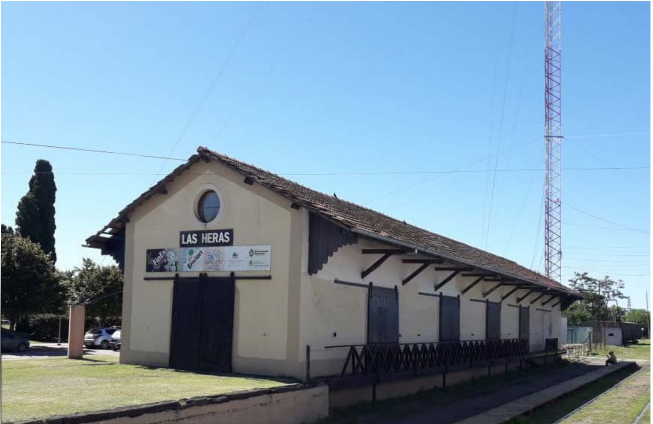
Figura 1. Estación de tren Gral. Las Heras, provincia de Buenos Aires. Fotografía: Di Pierro, Endrizzi.
